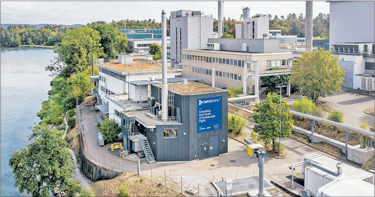
Die Zukunft des Fliegens ist schon da: nämlich am PSI, wo die neu eingeweihte «aerobrew»-Demonstrationsanlage täglich 50 Liter SAF produziert (Englisch für: Sustainable Aviation Fuel). Es ist die erste Anlage weltweit, die alle Herstellungsschritte für künstlichen Flugzeugtreibstoff aus Methanol unter einem Dach vereint. (Bild: PSI/Markus Fischer)
