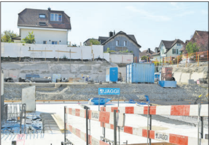
Ein Blick auf die Baustelle, wo Kirche und zwei Wohnhäuser entstehen.
